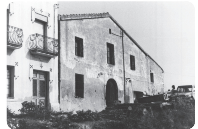
Estrada i Pinell, Gemma, 1982, vista de l'edifici (invarquit)
