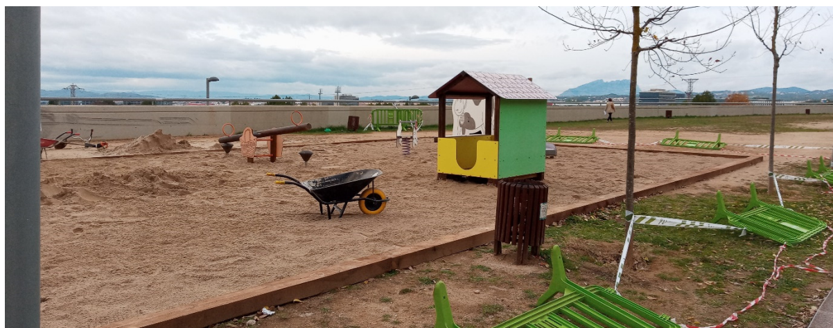
Imatges de l'execució del Parc del Patufet
